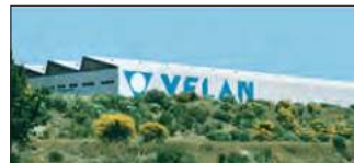
Lisbon, Portugal Velan Válvulas Industriais, Lda.
